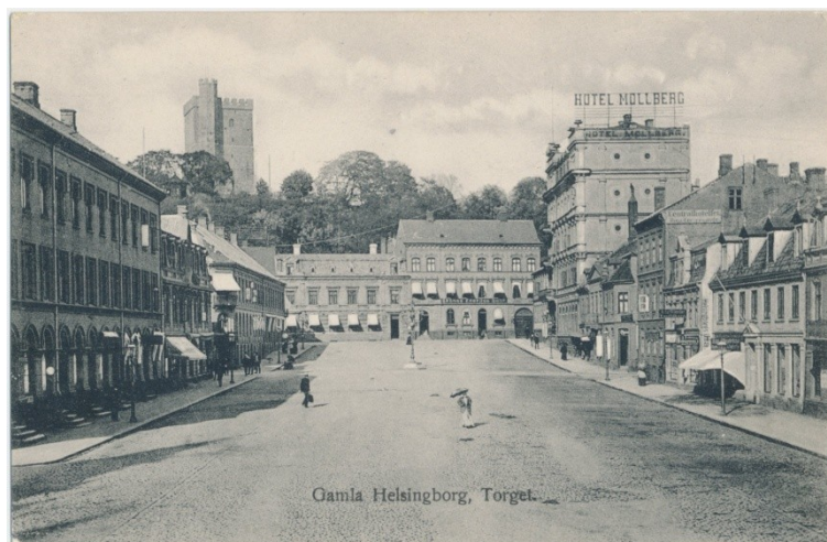
Stortorget's övre del innan bankens fastighet och terrasstrapporna
